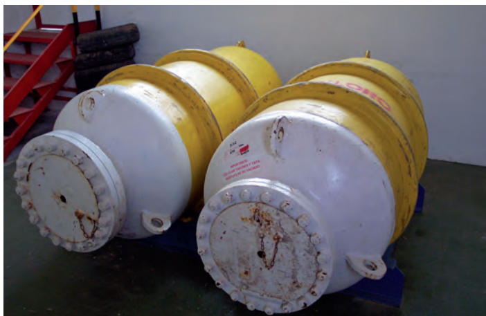
Figura 17 - Cilindros de cloro gaseoso. ETAP Palencia.
