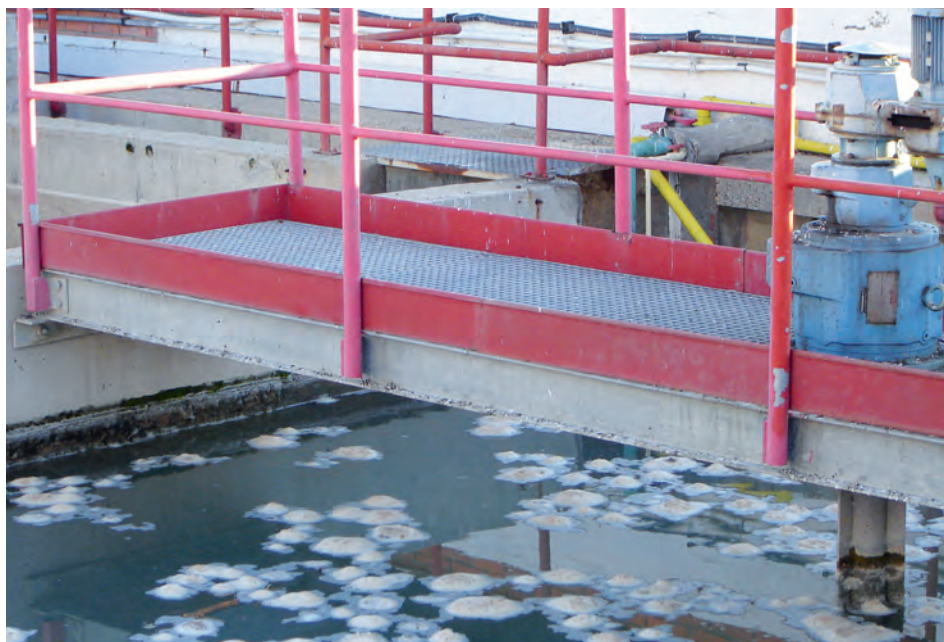
Figura 7- Flóculos formados en el proceso de floculación. ETAP Zamora.
